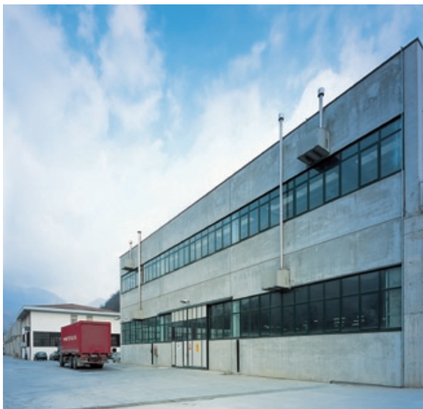
Фабрика в Sarezzo
